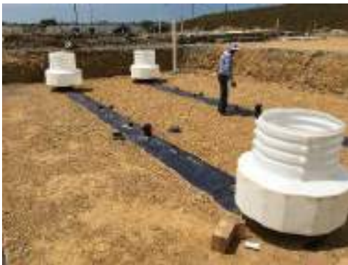
Figura 7-63, Compactación del Área e instalación de tuberías
