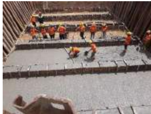
Figura 7-60, Adecuación de área de almacenamiento de tanques de combustibles
