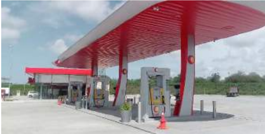
Figura 7-26, Área de venta de Diesel
