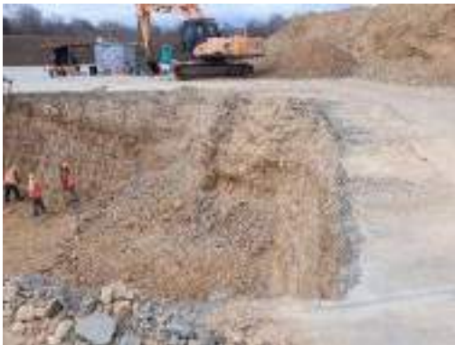
Figura 7-59, Excavación para la instalación de tanque de almacenamiento de combustible
