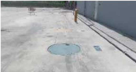
Figura 7-20, Acometida a tierra disponible en el area de almacenamiento de combustible
