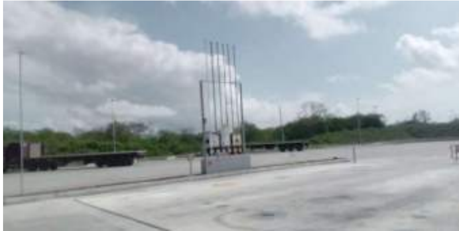
Figura 7-58, Área de recepción y almacenamiento de combustibles
