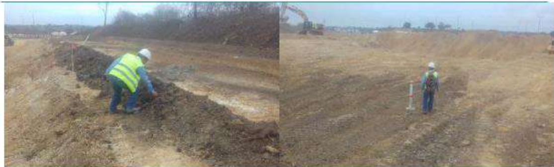
Foto 1-perimetro oeste, revisión de montículos dejados por maquinarias
