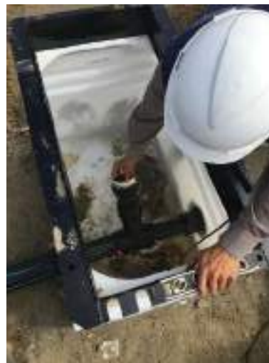
Figura 7-64, Verificación de la instalación de tubería
