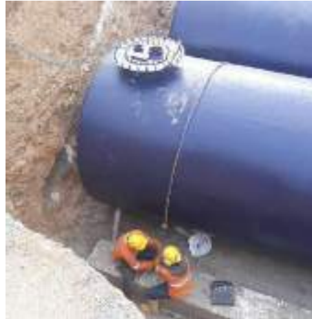
Figura 7-64, Verificación de la instalación de tubería
