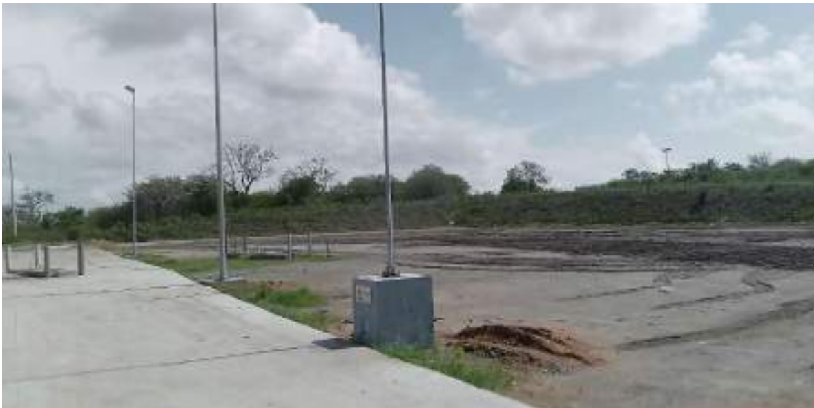
Figura 7-13, Área de POSOIL que falta construir
