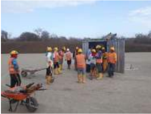
Figura 7-50, Campamento de obra construido con un contenedor metálico
