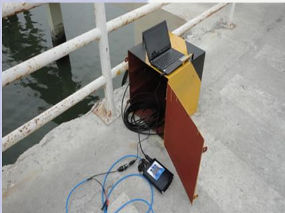
Instalación de Mareógrafo
