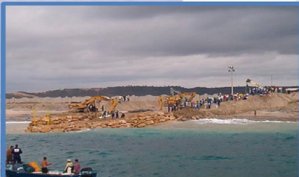
Lanzamiento Tubería 20", La Libertad, Oxxo
