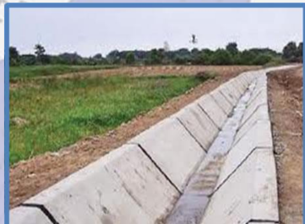
Canales de Riego
