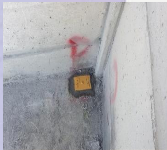
Colocación de placas
