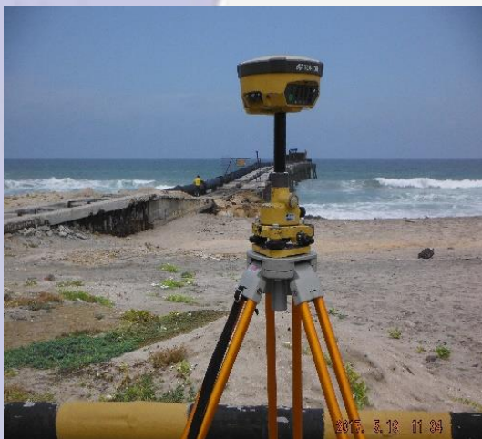
Ubicación Punto de Control
