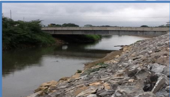
Zona vulnerable en Ribera de Río
